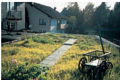
Ahtaasti rakennetuilla alueilla omalle katolle asennettu oleskelutila on erinomainen ratkaisu.
